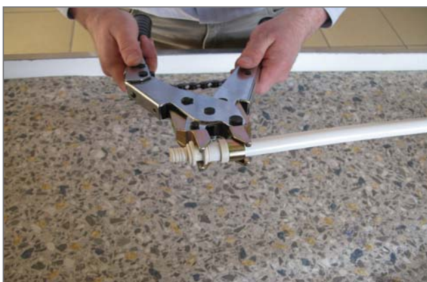
5. С помощью пресс инструмента (ручного или электрического) надвиньте натяжное кольцо на фитинг до упора (до щелчка).
