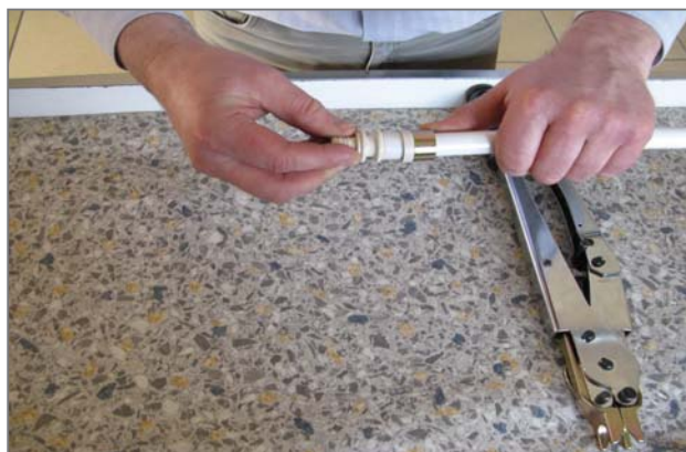
4. Вставьте фитинг в трубу до упора.
